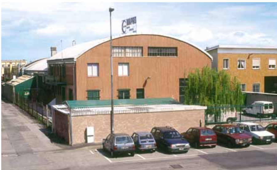
Produktionseinheit "Fermi": Drehschieberkompressoren
